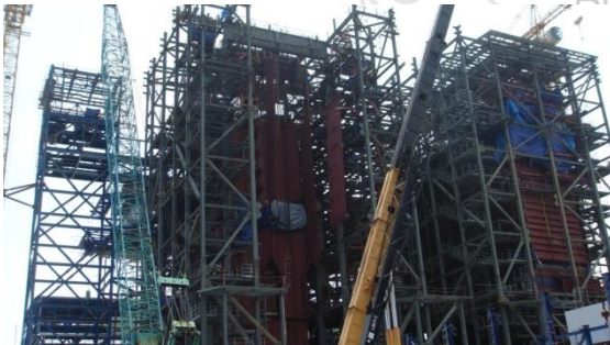
▷ Furnace Panel 설치 작업
