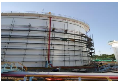
▷ 롯데케미칼 - 여수 NAPHTHA TANK SHELL 교체
