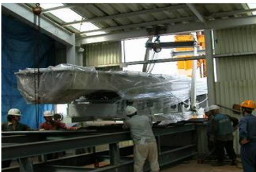
▷ Conveyor 설치
