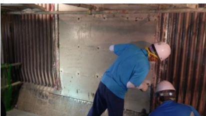
▷ 내화물 점검 점검을 통해 Crack이 발생하거나 소손된 내화물을 정비
