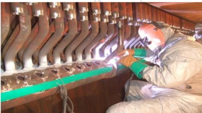
▷ Tube 교체 마모된 Tube 의 육성, 교체
