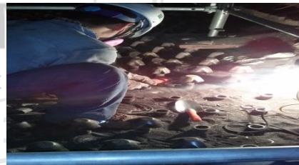
▷ Nozzle 점검 육안 및 두께점검을 통하여 마모된 Nozzle을 보강 및 교체
