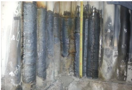
▷ Tube 파열 긴급 보수작업 (Overlay Welding)
