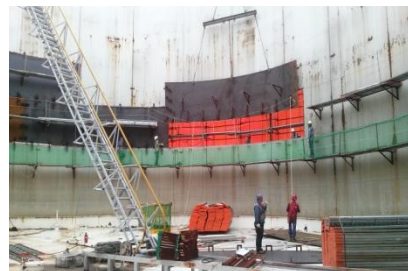
▷ 롯데케미칼 - 여수 NAPHTHA TANK SHELL 교체
