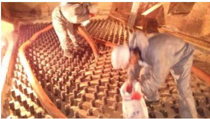
▷ ASH Cleaning 가동정지 후 내부 Cooling과 점검을 위해 최대한 신속히 Ash를 제거
